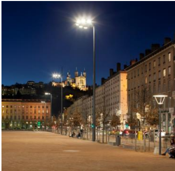
Lyon, Place Bellecour (cX.Boymond) : une solution de pilotage à l'armoire avec gestion des points lumineux, un scénario de gradation habituel et la modification des paramètres en fonction des événements de la place
